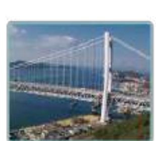
② 瀬戸大橋
